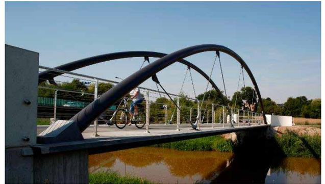
**2013** Geh- und Radwegbrücke über die Pleiße – UHPC-Platte in Segmentbauweise
