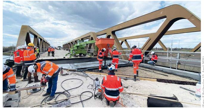
**Bild 11** Händischer Einbau der 1. Etappe der 35 mm starken UHFB-Schicht auf der Fahrbahnplatte, nachdem die Randborde bereits mit einer UHFB-Schutz- und Instandsetzungsschicht versehen wurden; die UHFB-Schicht wurde mit einer Rüttelbohle abgezogen
