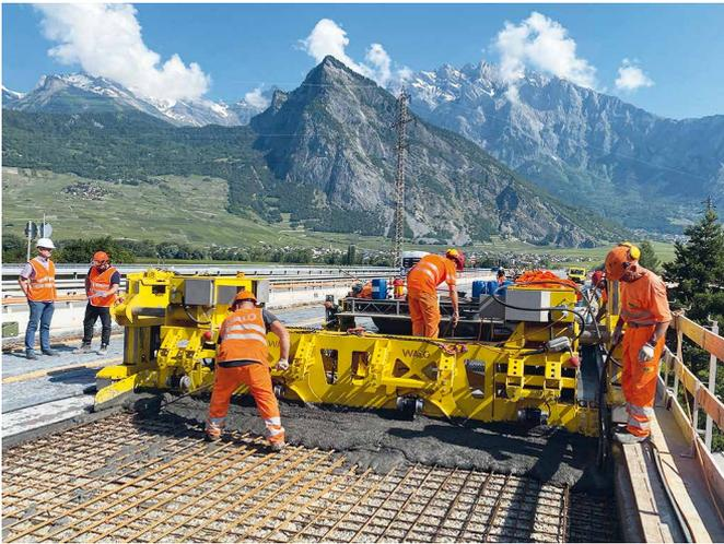
**Bild 14** Maschineller Einbau der 50 mm starken UHFB-Schicht auf der Fahrbahnplatte des Kastenträgers; die Maschine ist ein robuster Vibrierbalken, welcher den zähflüssigen thixotropen Frisch-UHFB mit Gefälleignung mit der erforderlichen Präzision einbringt
