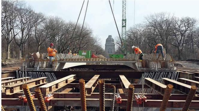
**Bild 14** Verlegen der Fertigteile
