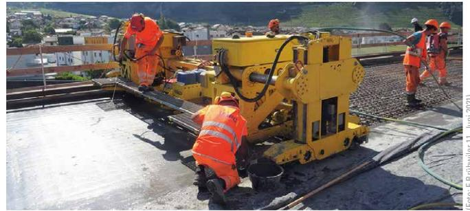
**Bild 15** Der mit Hochdruck-Wasserstrahlen vorbereitete Betonuntergrund muss mattfeucht sein, weshalb er kurz vor dem UHFB-Einbau nochmals befeuchtet wird (siehe Foto rechts); der eingebaute UHFB muss sofort nachbehandelt werden mit einem Curing-Mittel (links) und einer Abdeckung mit einer Plastikfolie
