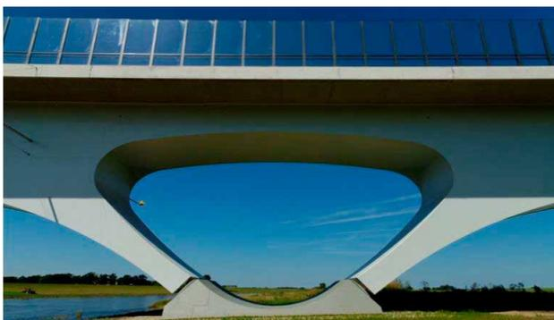
**2009** Elbebrücke Mühlberg, Betongelenk – Gutachten zur Rotationsfähigkeit
