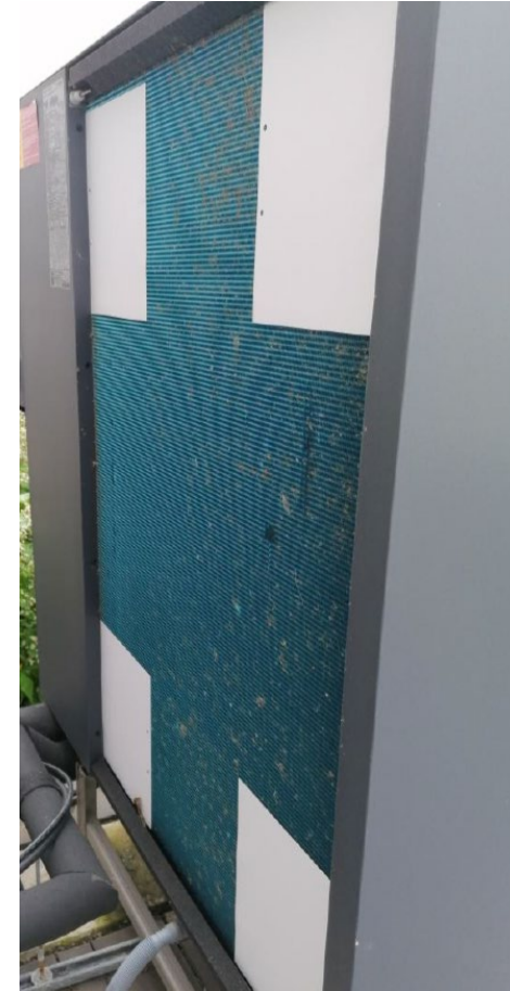
Abgedeckter Verdampfer
