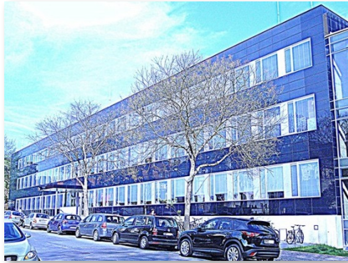
Pilotanlage „Walther-Hempel-Bau“ (Kälteauskopplung)
