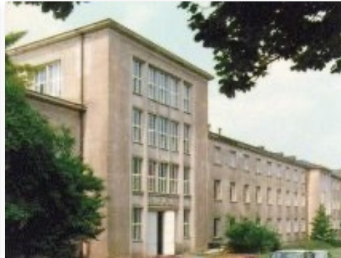
Pilot- und Demonstrationsanlage „Merkel-Bau“
