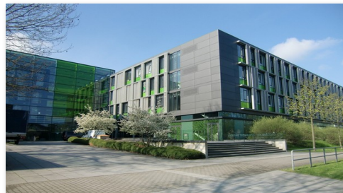
Ungekühlter Referenzfall „Andreas-Pfitzmann-Bau“
