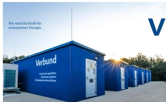
Abbildung 2: 20MW/21MWh Großbatteriespeicher in Diespeck nach Fertigstellung
