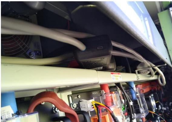
Abbildung 6: Messung der DC-Ströme an jedem Strang
