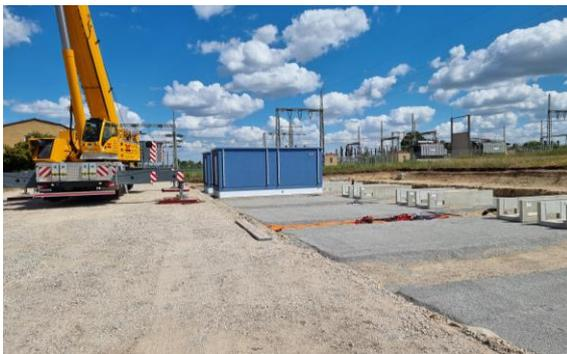
Abbildung 1: 20MW/21MWh Großbatteriespeicher in Iphofen in der Bauphase (Einheben der Batteriecontainer)
