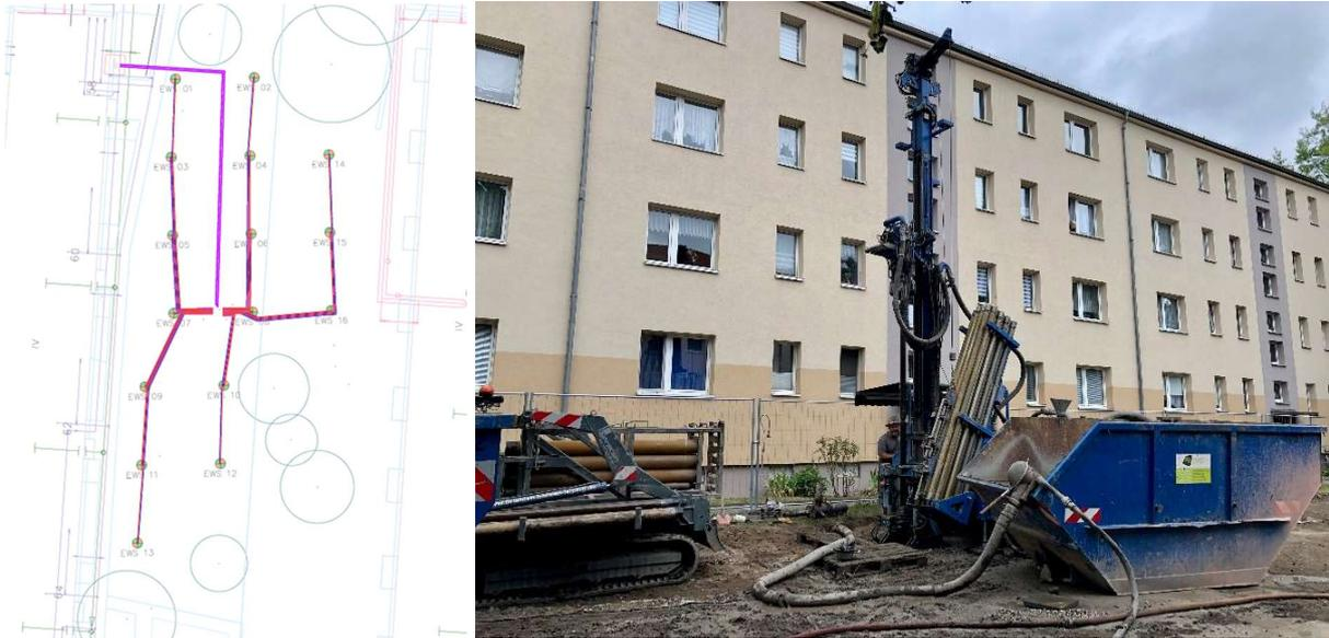
Abbildung 16: Konzeption Sondenfeld    Abbildung 17: Einbringung einer Doppel-U-Rohr-Sonde
