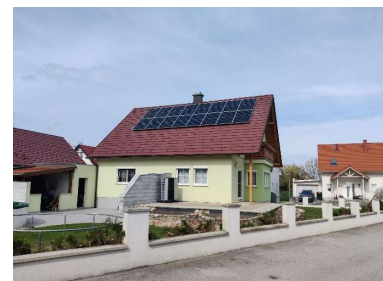
Abbildung 3: Kumulierte realisierte Anlagenleistung im Burgenland in Abhängigkeit von der Anlagenleistung (links). Beispiel einer typischen PV-Anlage angepasst an Eigenbedarf und Förderbedingungen; das Dachpotential wird nur teilweise genützt (rechts).
