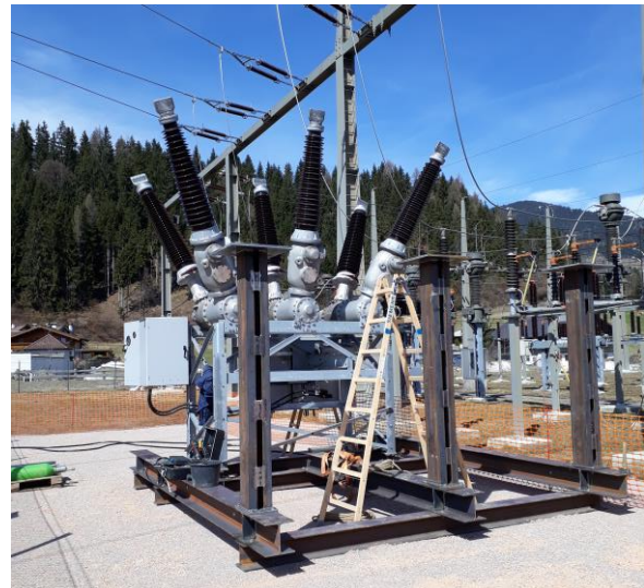
Abbildung 4: 110 kV Provisorium
