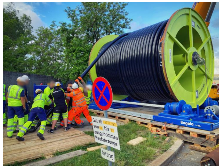
Abbildung 7: Zug des 380 kV – Kabels in Wien
