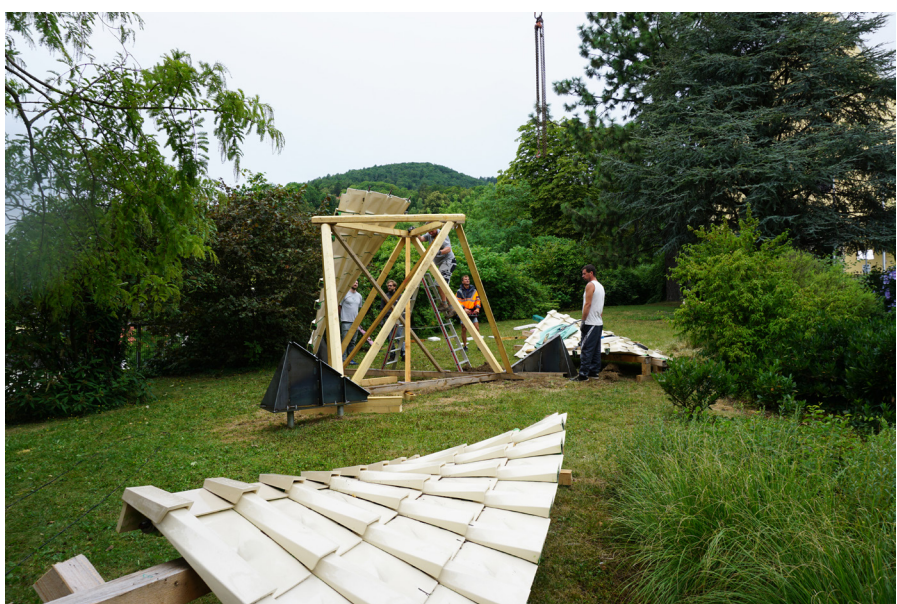
Der Aufbau erfolgt auf einem formgebenden und stützenden Gerüst. Schraubverbindungen sichern den Lastabtrag der Keramik-Beton-Verbund Struktur.
