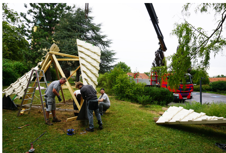
Der Aufbau erfolgt auf einem formgebenden und stützenden Gerüst. Schraubverbindungen sichern den Lastabtrag der Keramik-Beton-Verbund Struktur.
