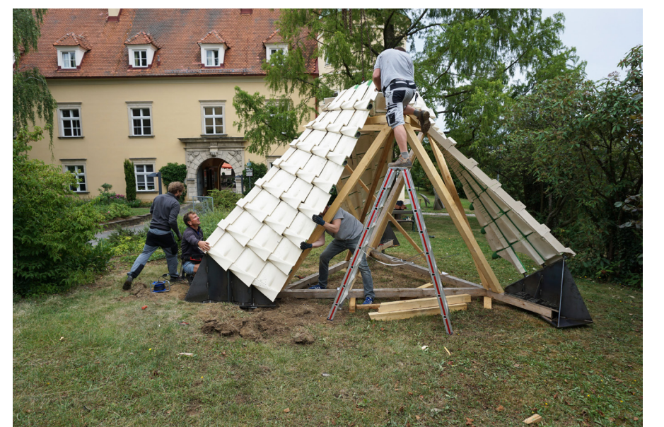
Der Aufbau erfolgt auf einem formgebenden und stützenden Gerüst. Schraubverbindungen sichern den Lastabtrag der Keramik-Beton-Verbund Struktur.
