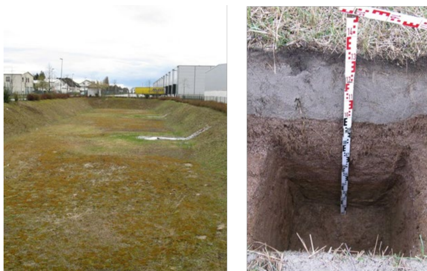
Abbildung 2: Versickerungsmulde Hartdach (MD; links) und Bodenprofil (rechts). Quelle: Bioplan Landeskulturgesellschaft.
