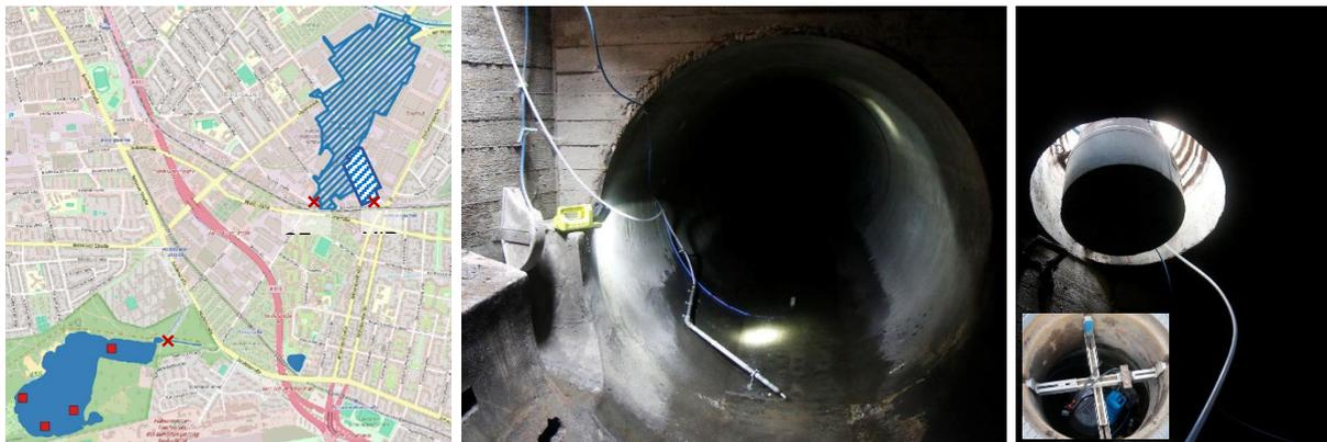
Abbildung 1: Links: Untersuchungsgebiet mit Probennahmepunkten für Regenwasserabfluss (Kreuze) und im See (Quadrate). Mitte und rechts: Installation von Durchflusssensor und Probenehmer im Regenkanal.
