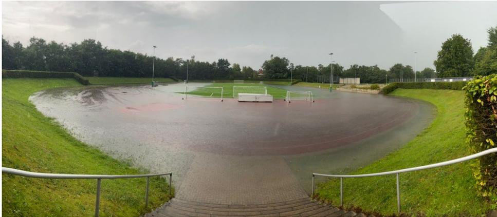
Abbildung 5: Aufstau von Wasser auf der Oberfläche der Sportanlage bei dem Starkregenereignis vom 07.08.2024 (Quelle: Bezirksamt Hamburg-Mitte).
