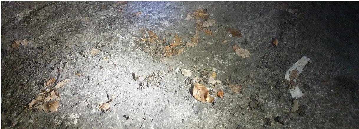
Abbildung 21: Sediment einer Regenrückhalteanlage im Trennsystem.
