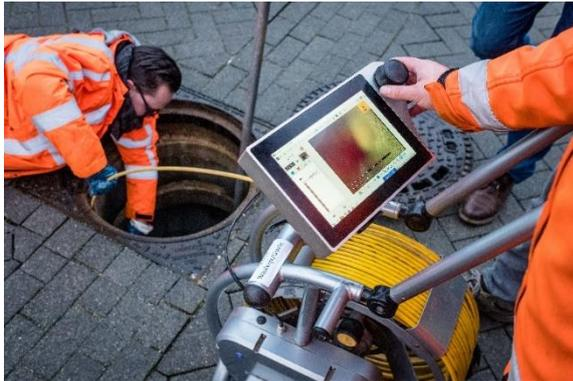
Abbildung 5: Visuelle Inspektion mittels einer Schiebekamera
