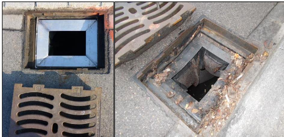
Abbildung 4: Leiteinrichtung auf rechteckigem Einlaufrost-Rahmen (Einlaufrost daneben) in einem Strassenablauf SA (links: Aluminium; rechts (vormals): Gummi)
