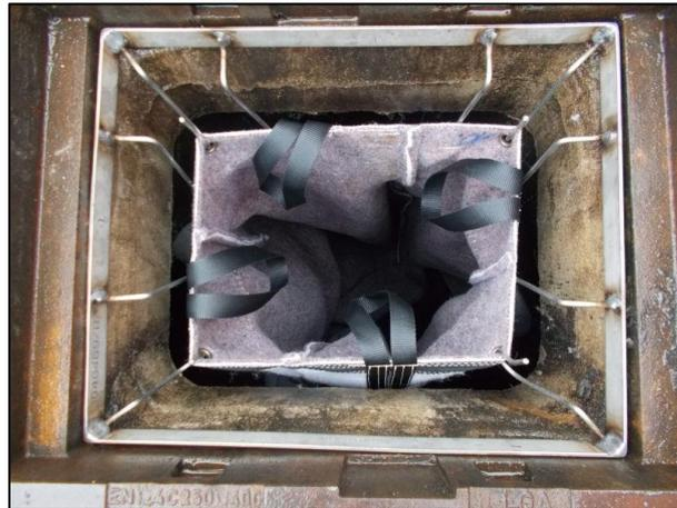
Abbildung 3: Tragkonstruktion im Schlammsammler mit rechteckigem Einlaufrost-Rahmen und eingehängtem GTS
