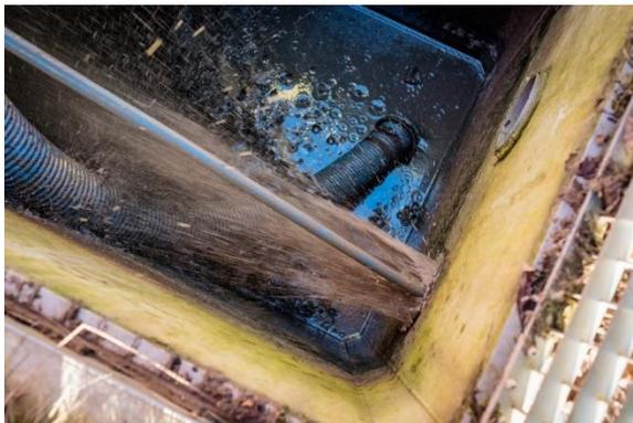
Abbildung 6: Rückspülen des ‚Filterkuchens‘ in den Schacht
