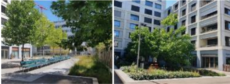
Rückhalt und Versickerung von Regenwasser in bepflanzten Gräben (links); Park mit Bäumen im Innenhof über eine Tiefgarage (Fotos: Brigitte Kisseleff, ERZ)
