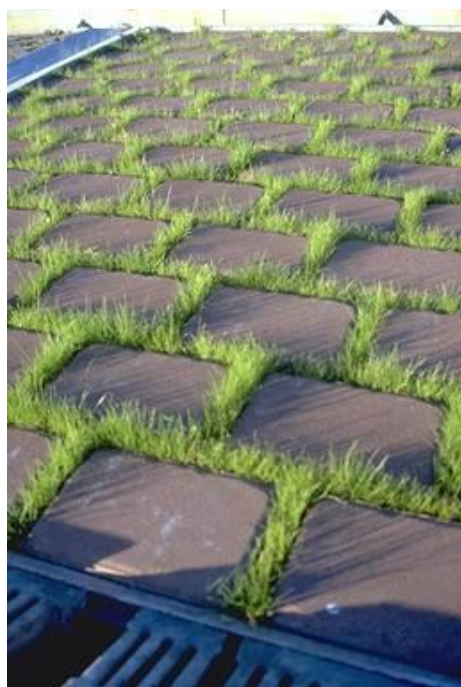
Pflaster- ung mit Rasen- gitter- steinen
