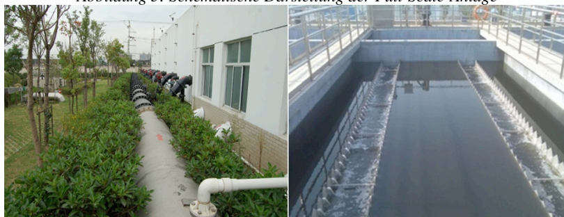
Abbildung 6: Der statische Mischer und Röhrenabscheider von Anlage
