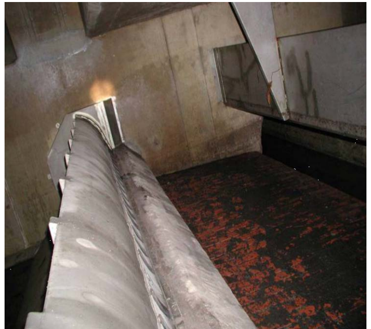
Abbildung 3: Kippwehr (Mischwasserüberlauf Nr. 1 und 6)
