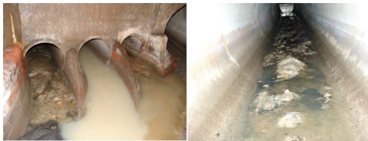
Abbildung 4: Ablagerungen Düker Mühlgraben (links) und stromab Kanalspüler Altstadtsammler (rechts).
