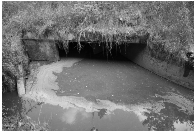
Abbildung 1: Direkte Einleitung von oberflächlich abfließendem Regenabwasser ohne vorherige Behandlung in ein kleines Fließgewässer.
