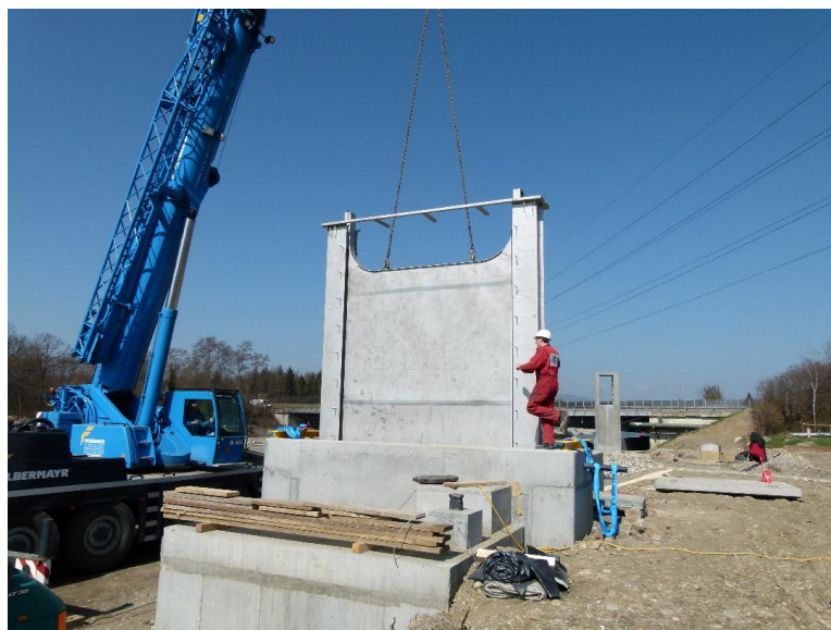
Abbildung 16: Kaskadenwehr – Montage (Foto: P. Zorko)
