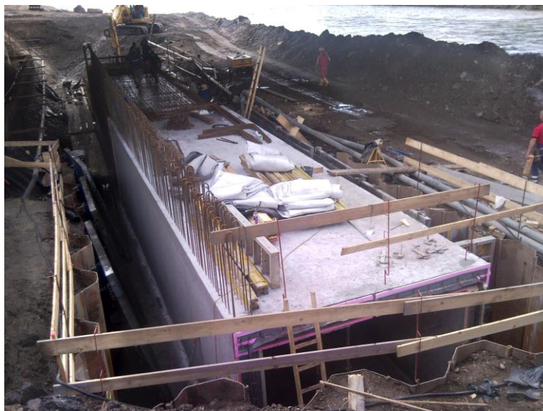
Abbildung 15: Baufortschritt – Baustraße und Spundwandkasten (Foto: P. Zorko)
