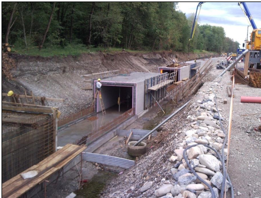
Abbildung 14: Baufortschritt - Bodenplatte und Wände (Foto: P. Zorko)
