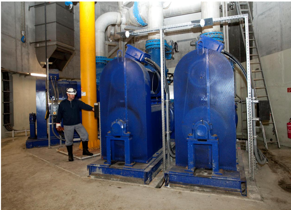
Abbildung 3-5: Entleerungspumpwerk im Bereich Betreuungsschacht Stadtpark
