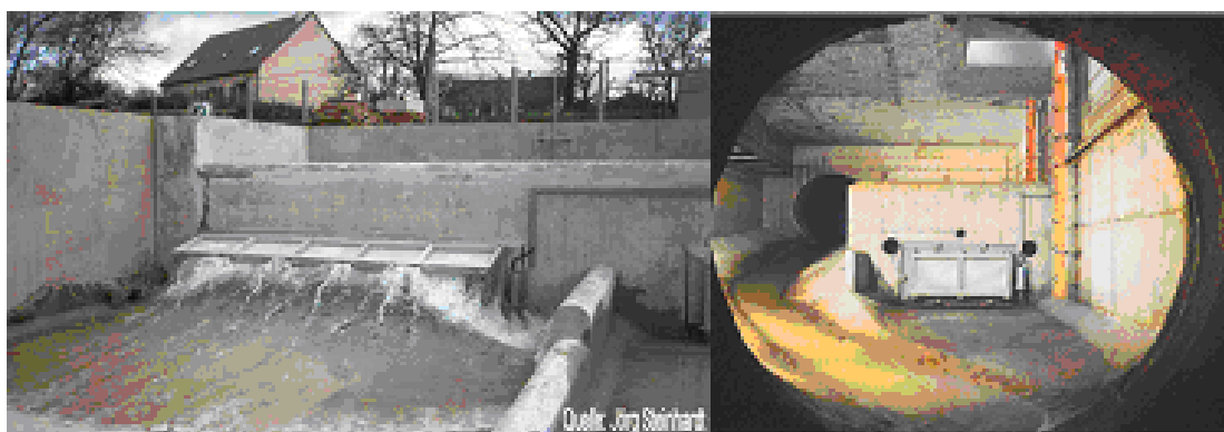
Abbildung 6: Spülklappensystem in einem Regenbecken (links) und einem Stauraumkanal (rechts) (Steinhardt GmbH)
