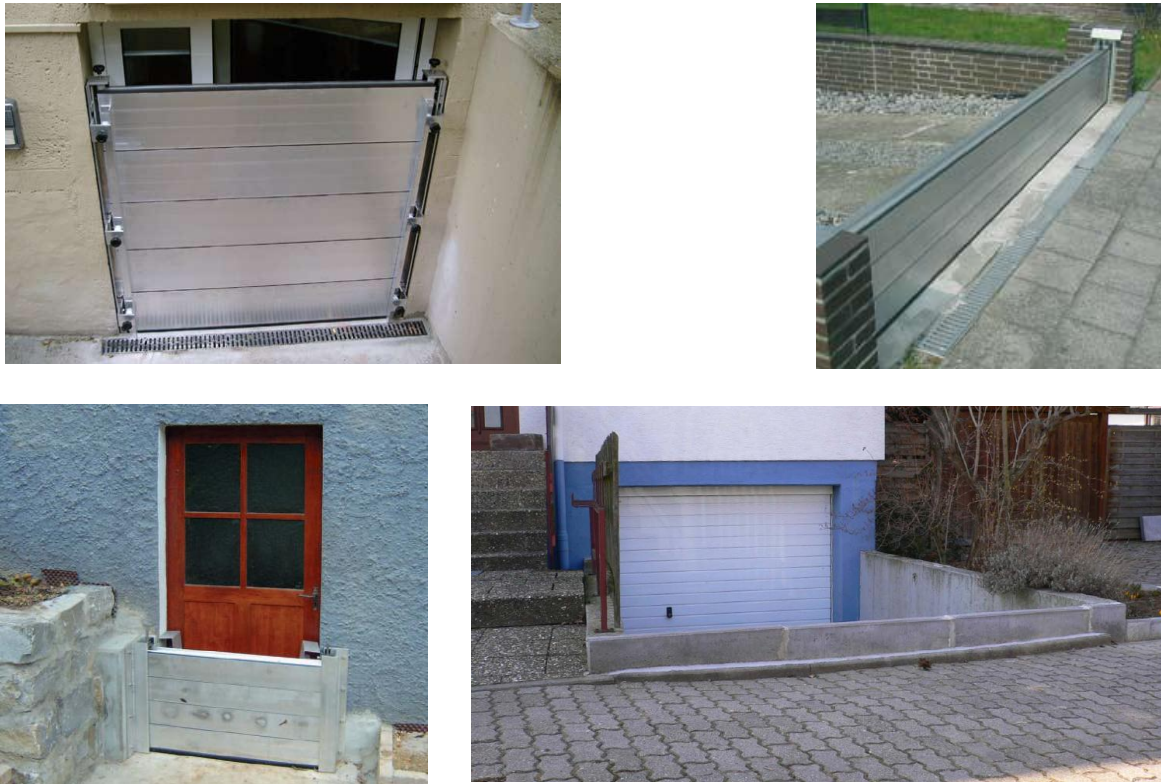
Abbildung 1: Maßnahmen des Objektschutzes zur Vermeidung von oberflächlichem Wassereintritt („bedingt empfehlenswert“)
