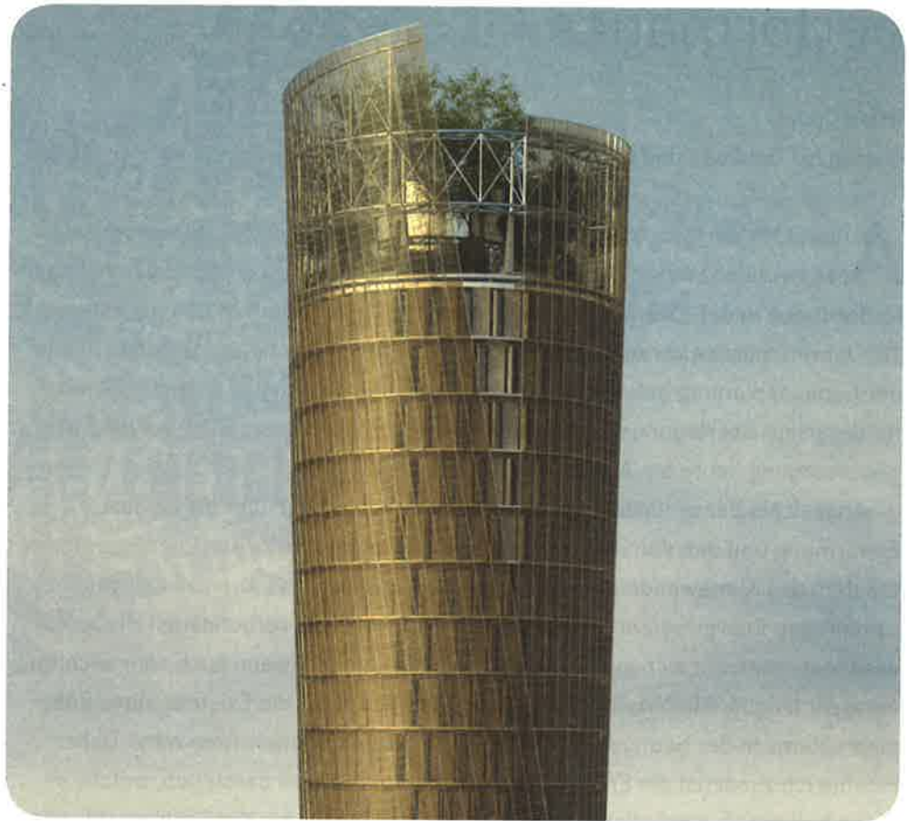
Form follows energy – das wird das Motto für Gebäude im 22. Jahrhundert.
