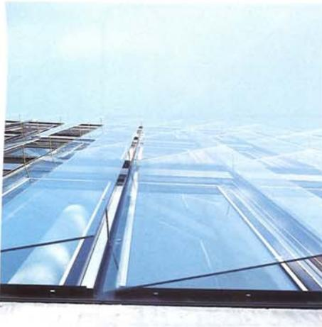
Im Sommerfall öffnen sich die äußeren Scheiben der Fassade. Einer Überhitzung des Innenraums wird somit vorgebeugt.
