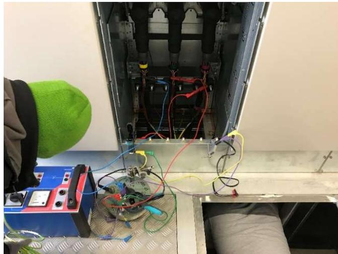
*Abbildung 4.5: Strominjektion über die Kabelschirme der Mittelspannungskabel*
