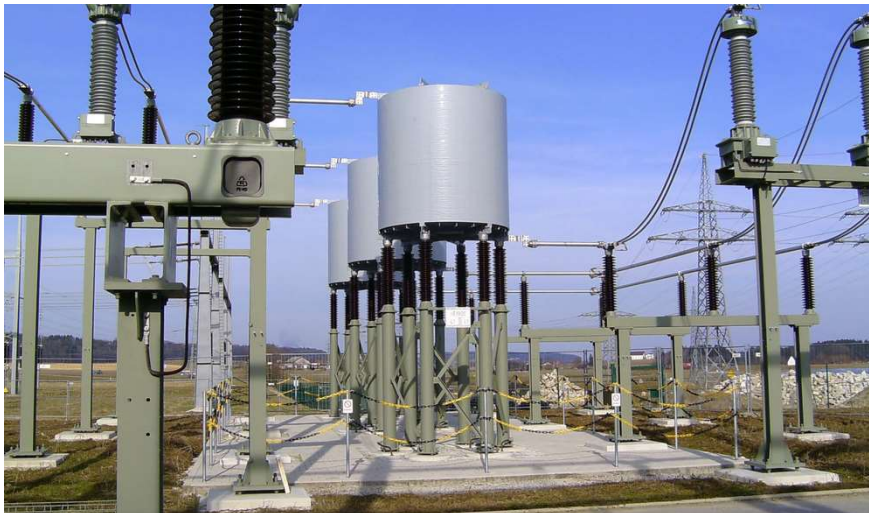
Abbildung 2-2: Längsdrossel 110 kV [6]
