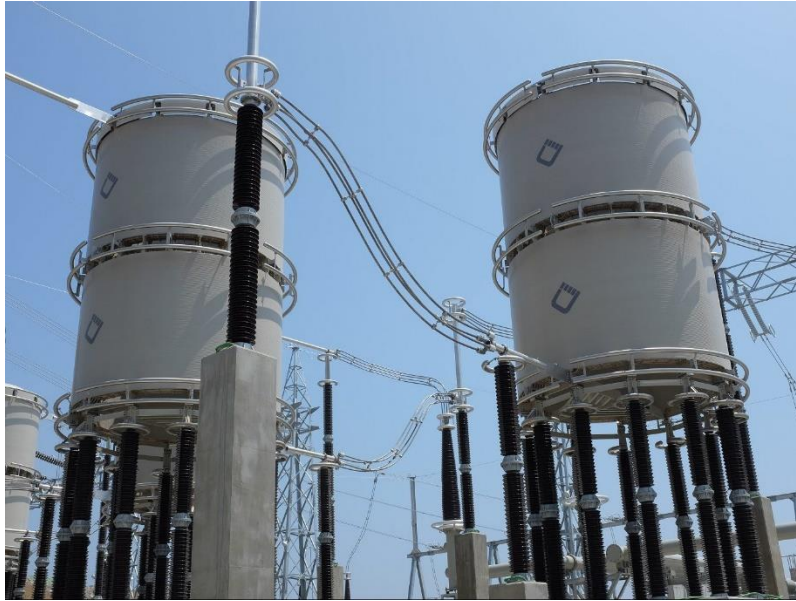
Abbildung 3 Luftdrosseln (Quelle: [1])
