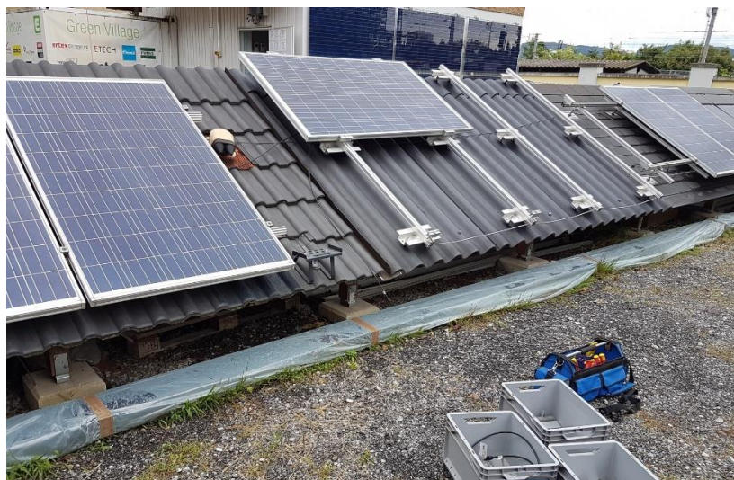
Abbildung 24: Montage der PV-Module an die dafür vor-gesehenen Tragschienenysteme am Versuchsdach „Bramac“
