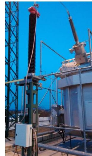
Abb. 2: Transformator-Sternpunktmessung
