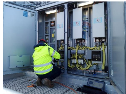
Abbildung 7: Phasenmessung
