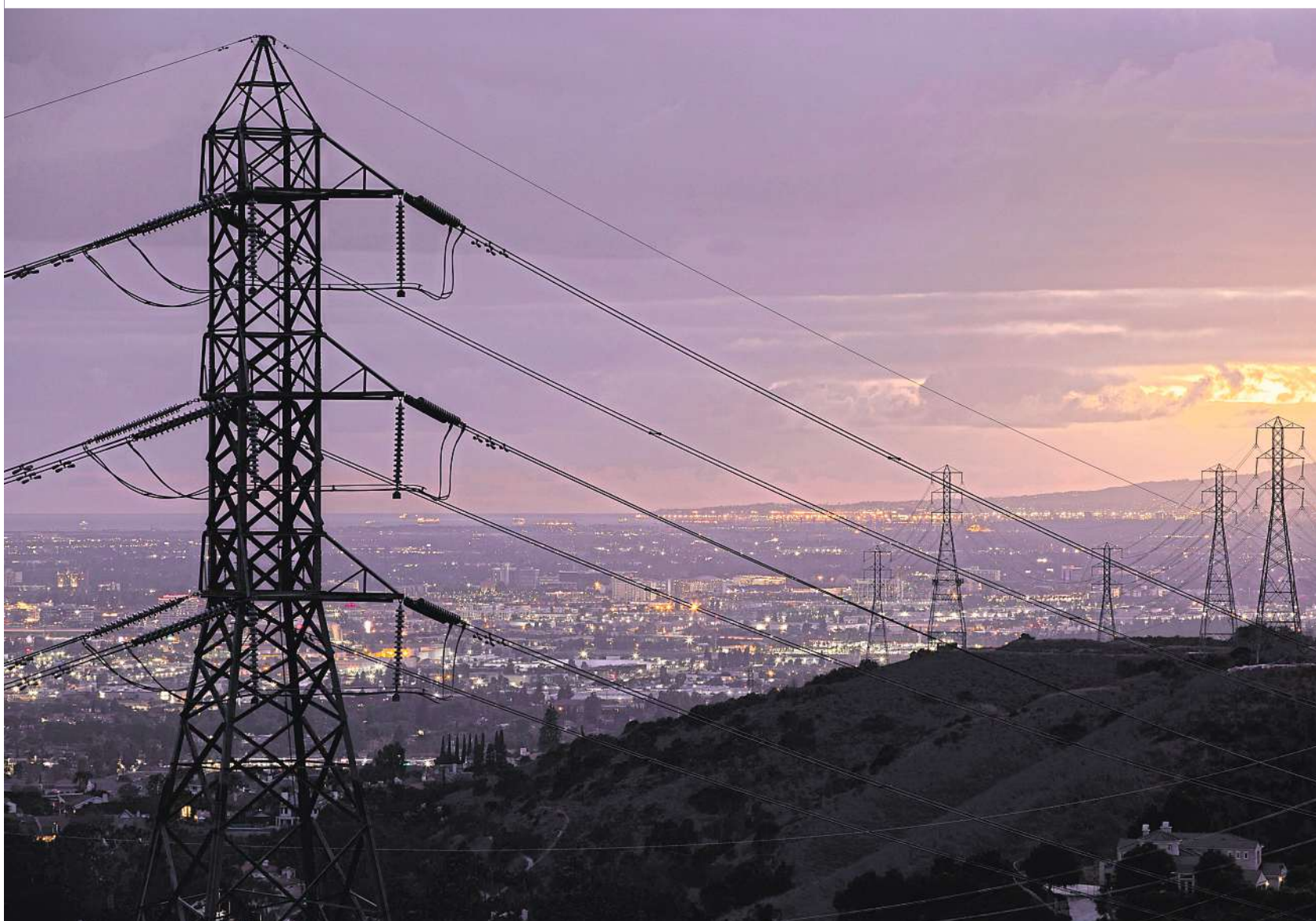
Was einen weitreichenden Stromausfall so erschreckend macht, ist der Kontrollverlust. Auf viele Szenarien kann man sich aber gut vorbereiten
