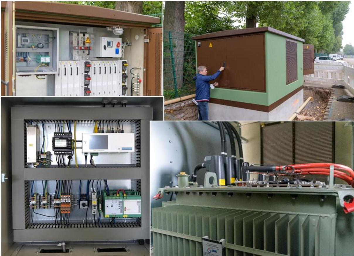
Abbildung 5: Ortsnetzstation mit Elektronisch Regelbarem Transformator
