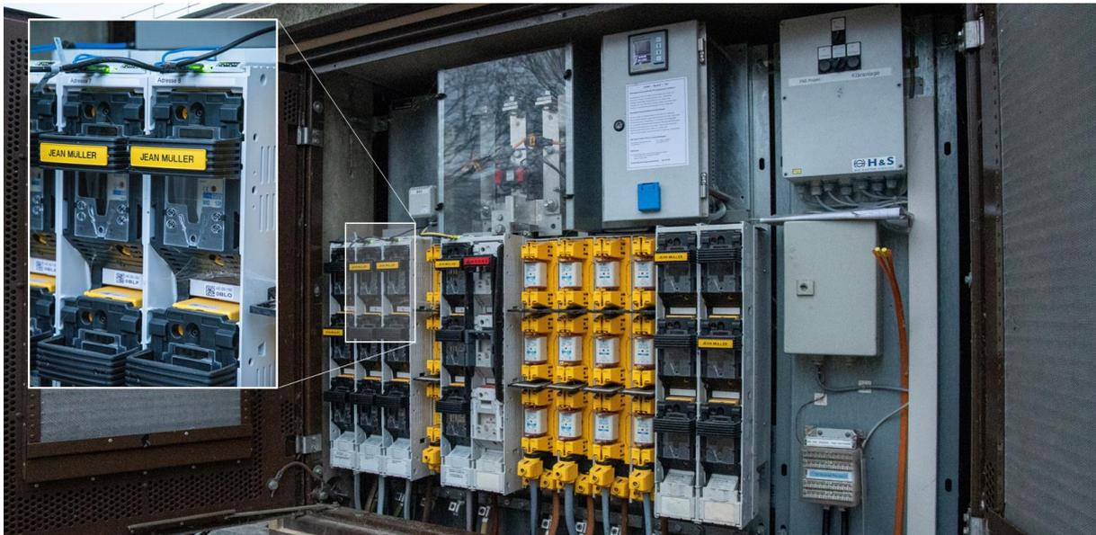
Abbildung 8: PLPlano-Messleisten in der Trafostation (mit Detailausschnitt)
