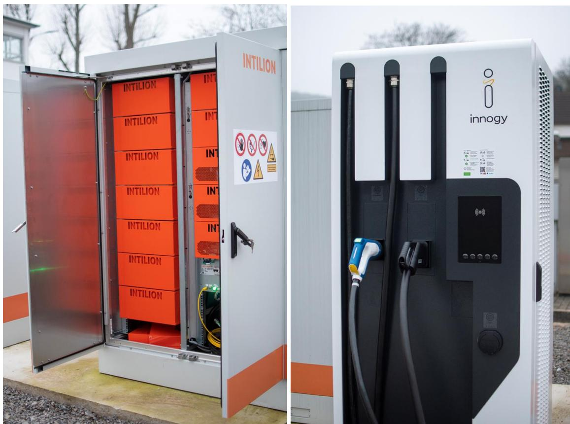
Abbildung 7: Batteriespeichereinheit (links) und neue Ladestation zur Integration in das Leistungsmanagement (rechts)
