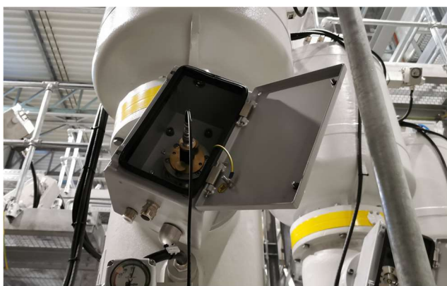
Abbildung 5: VFT Abgriff, 400kV SF6, bis 1 GHz
