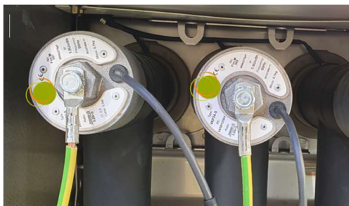
Abbildung 3: C-Teiler in T-Steckern, MS, 150kHz, Artemes VAP-24-S
