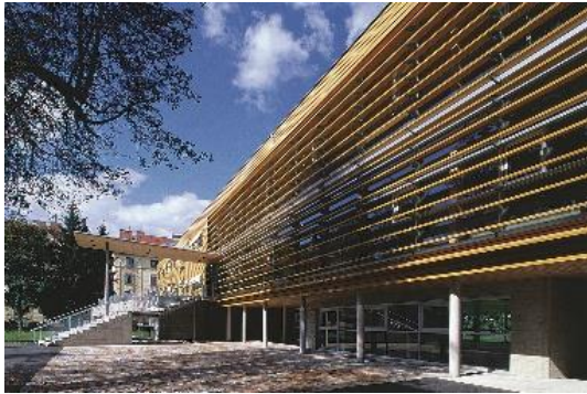
Volksschule Karl-Morre Fertigstellung 2002 654 m 3 Holz
