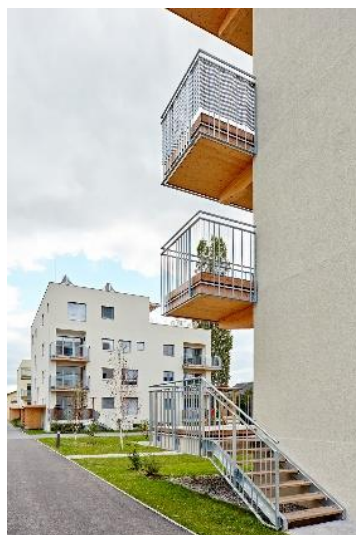
Wohnbau Reininghaus Süd Fertigstellung 2015 4.400 m 3 Holz
