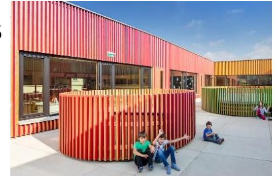
Bildungscampus Algersdorf Fertigstellung 2016 226 m 3 Holz
