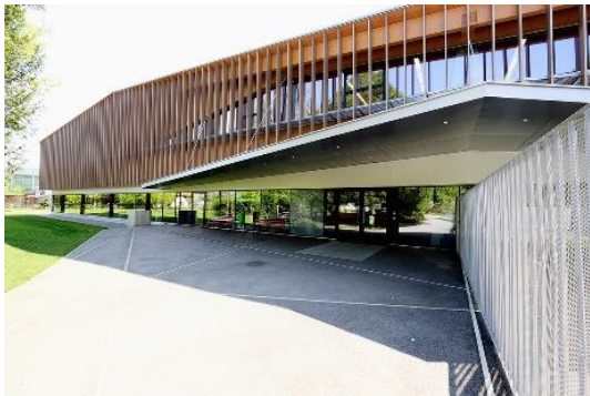
Turnsaal Konvent der Ursulinen Fertigstellung 2013 539 m 3 Holz
