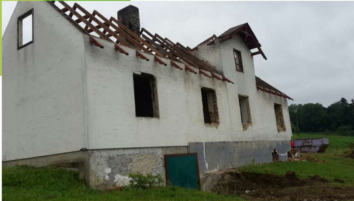
Foto: Erdbau Taucher
