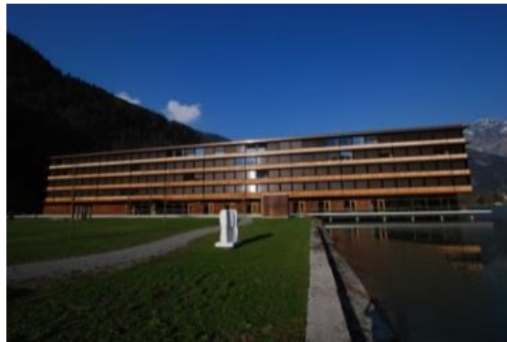
IZM - Illwerke (Vandans)
