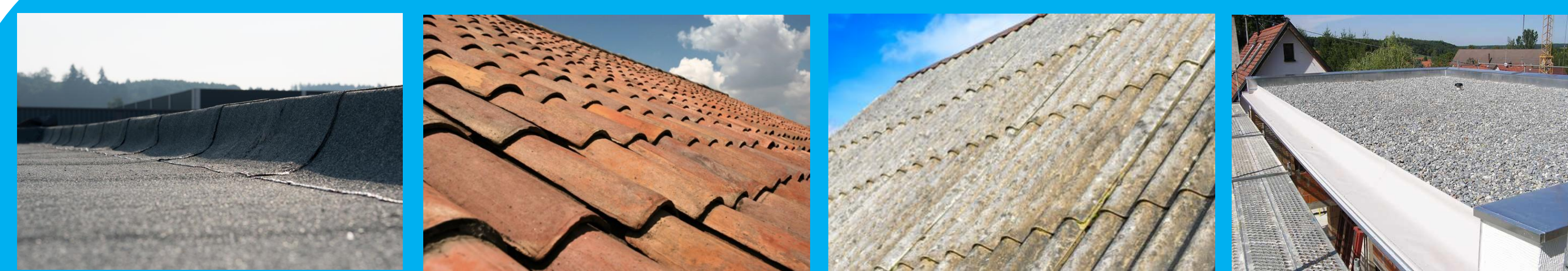
Bitumendach (BD) Betonsteindach (BDS) Asbestbetondach (ABD) Kiesflachdach (KFD)
