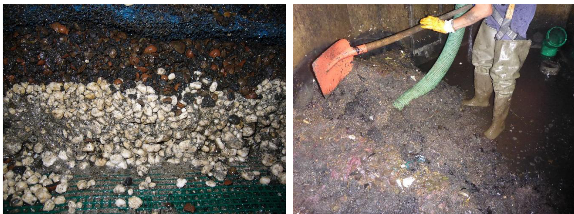
Abbildung 6: Feststoffbeladung innerhalb der Filterschichten (links) und Schlammanfall in der Sedimentationsstufe (rechts)
