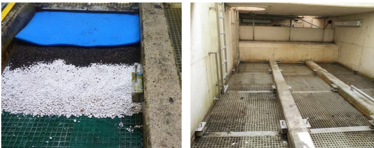
Abbildung 1: Mehrstufiger Aufbau des Filters (links) und Blick auf die drei Straßen und das senkrecht angeströmte Wehr im Zulaufbereich des TRF Fleute (rechts)
