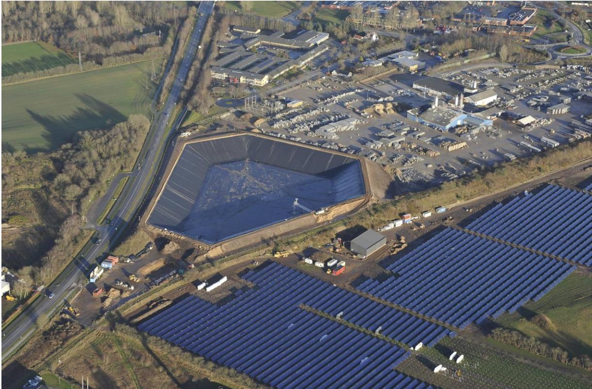
Abbildung 1: Bisher größter existierender Großwärmespeicher, ein wassergefüllter Erdbeckenspeicher mit einem Speichervolumen von etwa 200.000 m<sup>3</sup>, in Vojs, Dänemark. Bildquelle: Arcon-Sunmark.
