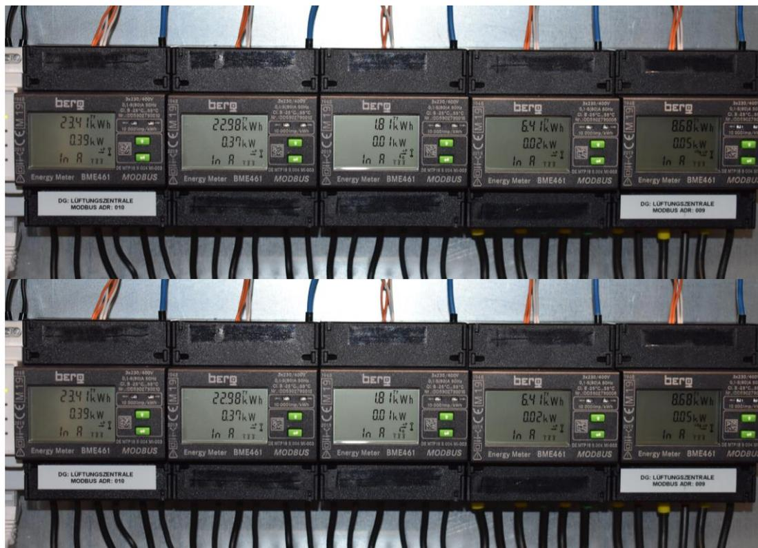
Abbildung 4 Elektronischer Wirk- und Blindenergiezähler BME 461 [10]
