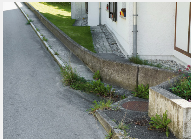
Fig. 6 Selbst wenige Zentimeter hohe Längsstrukturen wie Strassenränder beeinflussen den Fliessweg des Wassers entscheidend (links). Mit einer Ablenkmauer kann das Wasser gezielt am Gebäude vorbeigeleitet werden (rechts). (Foto: geo7 AG)
