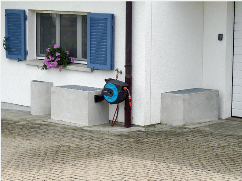
Fig. 7 Über den Hochwasserpegel angehobene Lüftungs- und Lichtschachtöffnungen. (Foto: VKG)
