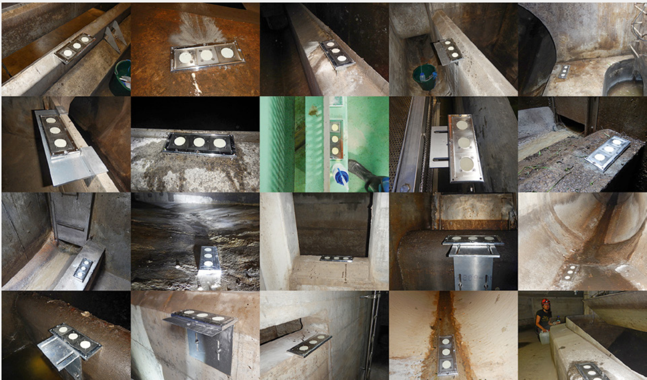
Fig. 3 Installationen der Passivsammler (Triplikate) zur Probennahme in 20 Mischabwasserentlastungen.
