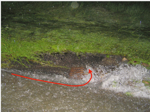
Fig. 3 Wirbelbildung: Welcher Anteil des abfliessenden Wassers gelangt überhaupt in die Kanalisation...
