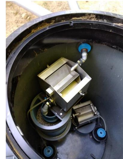
Blick in den Schacht mit dem integrierten Filter und zwei Kippwaagen
