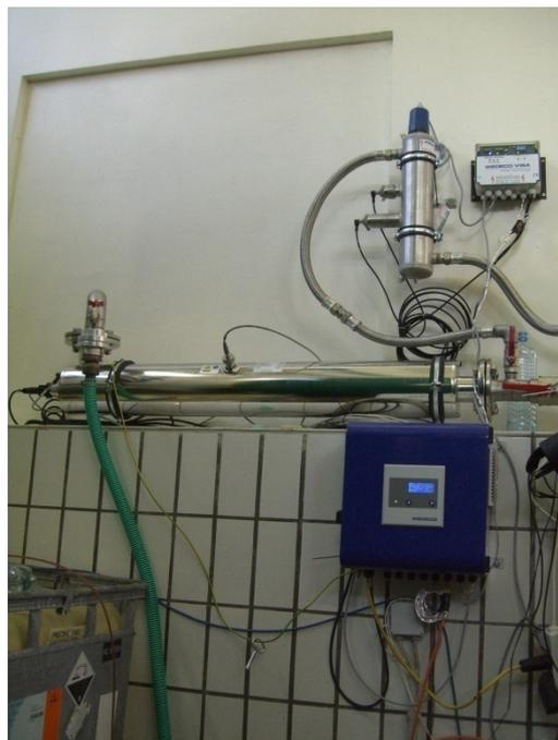
**Abbildung 25: UV-Desinfektionsanlage**
