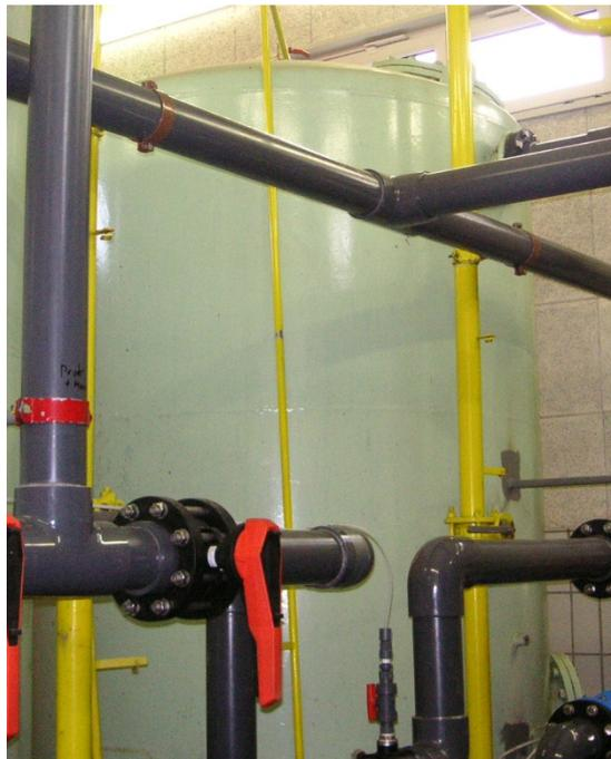
Abbildung 19: Sandfilter II (Entmanganung)
