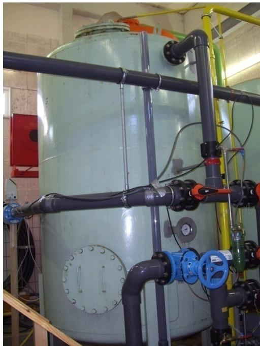
Abbildung 18: Sandfilter I (Flockenfiltration und Enteisung)
