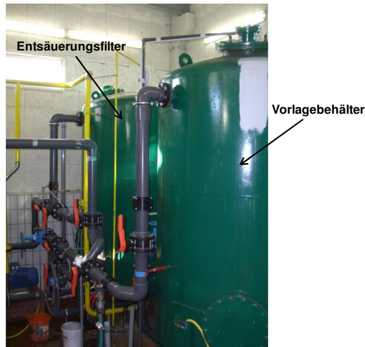
Abbildung 20: Sandfilter III (Entsäuerung) + Vorlagebehälter
