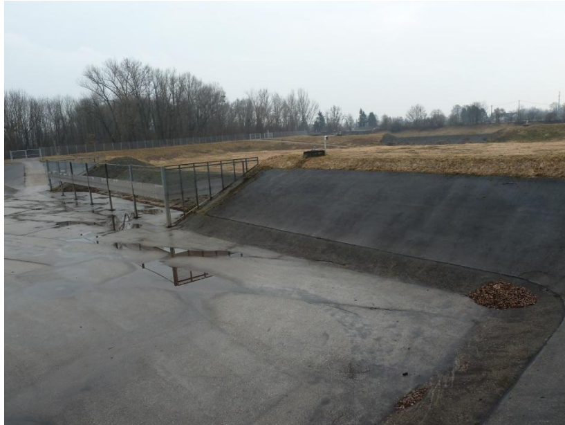
Abbildung 2-5: Mischwasserrückhaltebecken Weikerlsee-Becken 1
