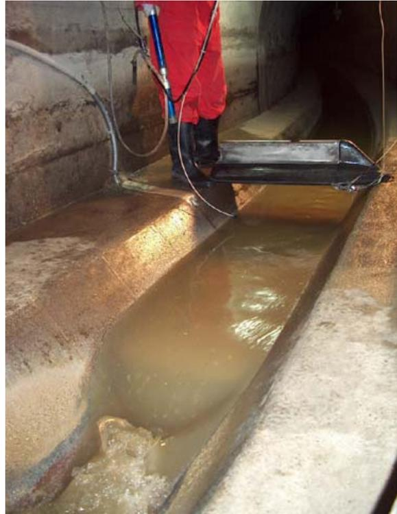
**Abb. 3.13** Bypass neu, Staublechströmung und ausgebaute s::can-Sonde
