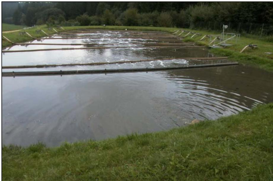
**Abbildung 4-4: Anoxische Zone des Belüftungsteiches 1**
