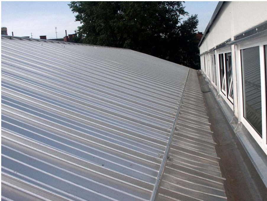
Abb. 5.3 Ansicht eines Sheddaches mit der Regenrinne
