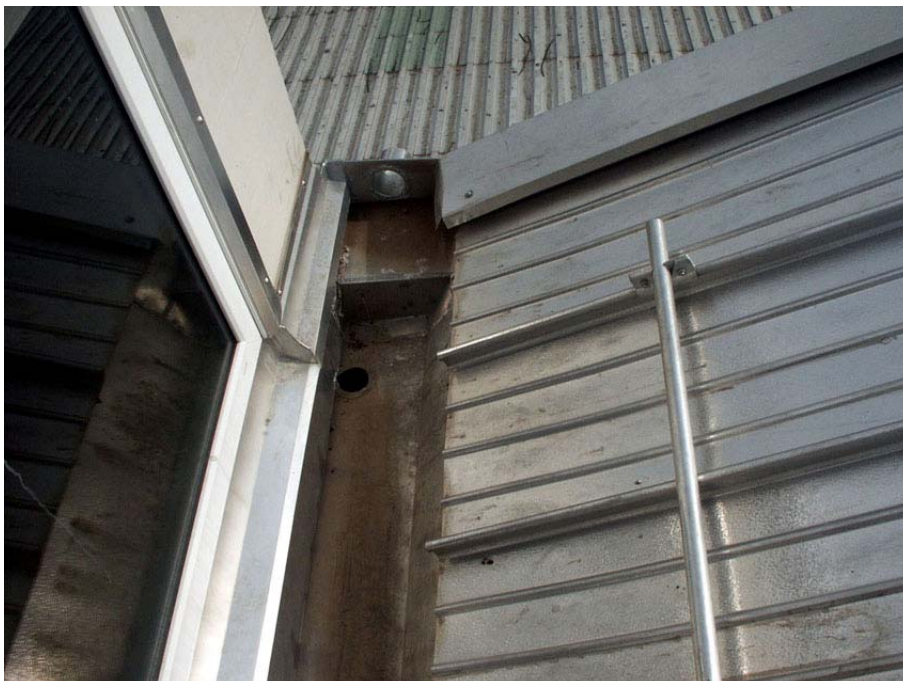
Abb. 5.4 Detail: Anschluss an das Fallrohr
