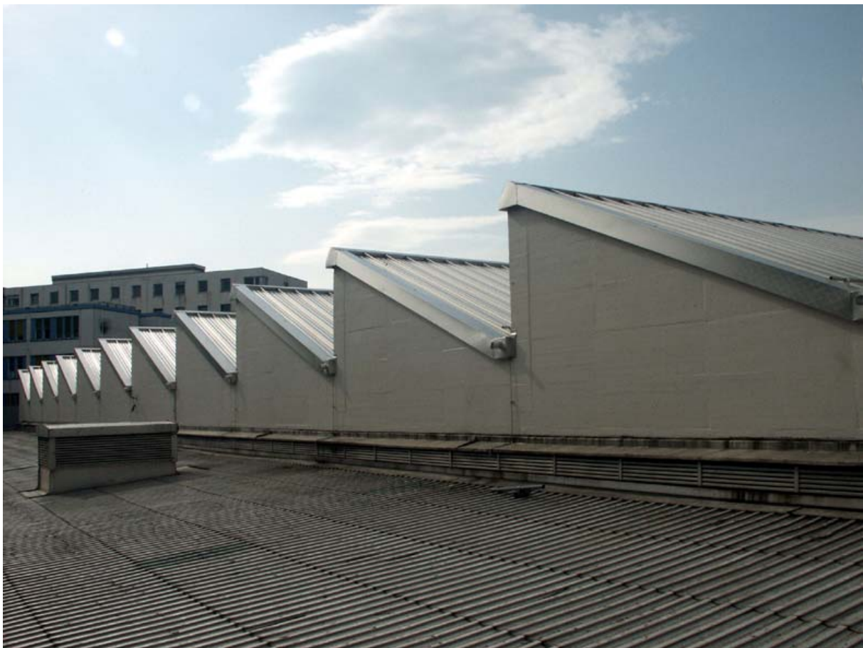
Abb. 5.2 Dachfläche des Wasserbaugebäudes
