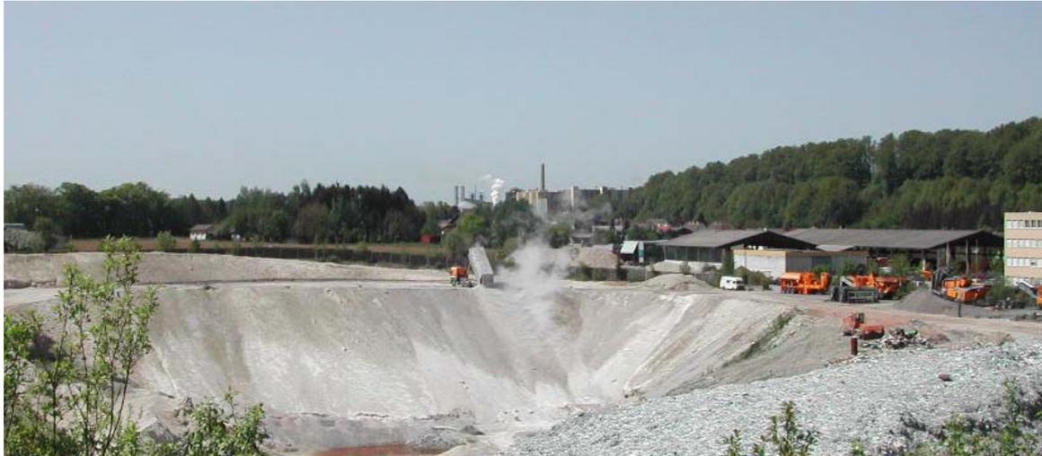
**Abb. 16: Kippvorgang, Wasserdampf entweicht von der 80°C heißen Asche**
