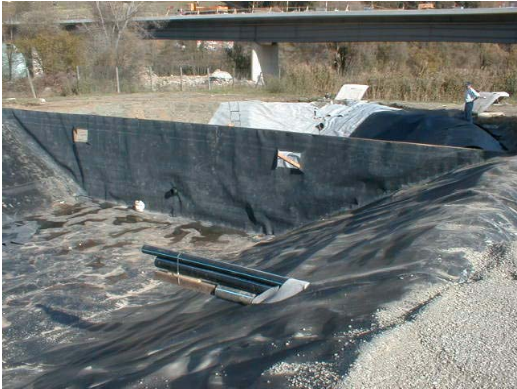
Abbildung 4: Umbau Teich I
